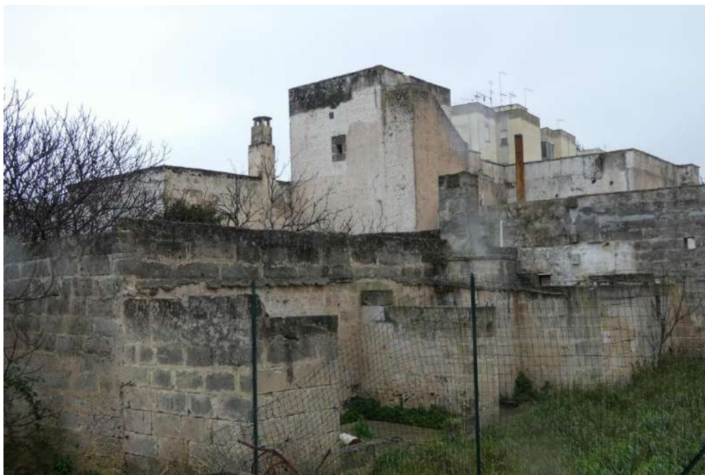
Figura 18. Area di intervento. Edificio 4, esterno, da SW.
