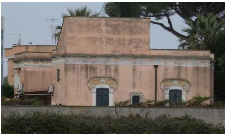
Figura 7. Fabbricato a W dell'area di intervento.
