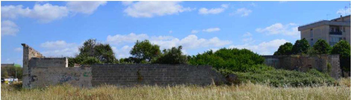
Figura 4-78. Vegetazione cresciuta all'interno del rudere.
