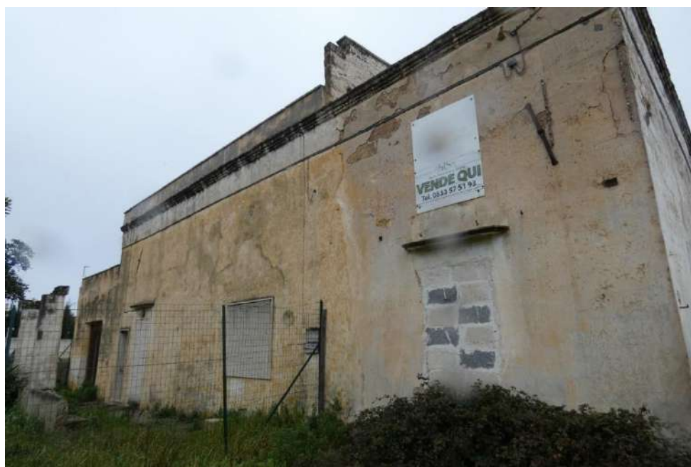
Figura 19. Area di intervento. Edificio 4, prospetto principale.
