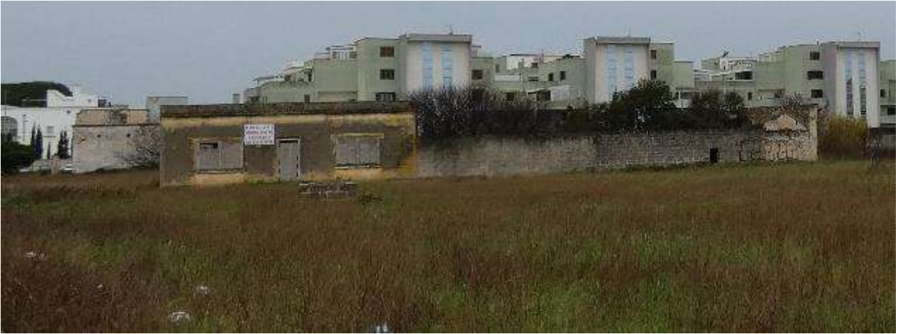
Figura 10. Area di intervento. Edificio 1-2, da N.
