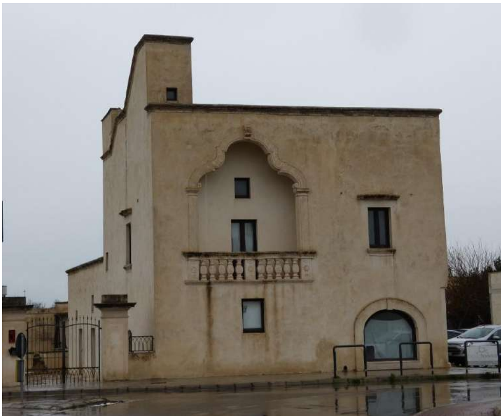
Figura 6. Fabbricato a NE dell'area di intervento.
