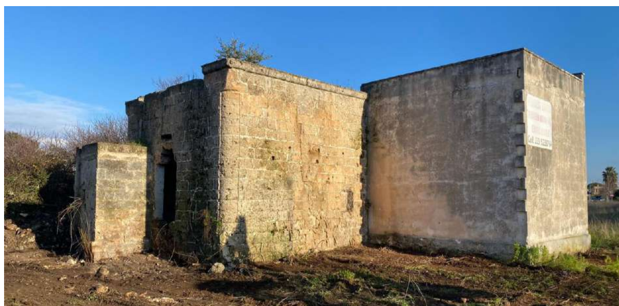
Figura 15. Area di intervento. Edificio 2-3, da S.
