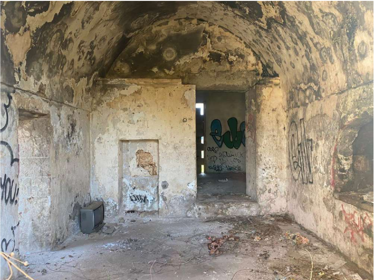
Figura 17. Area di intervento. Edificio 3, interno.
