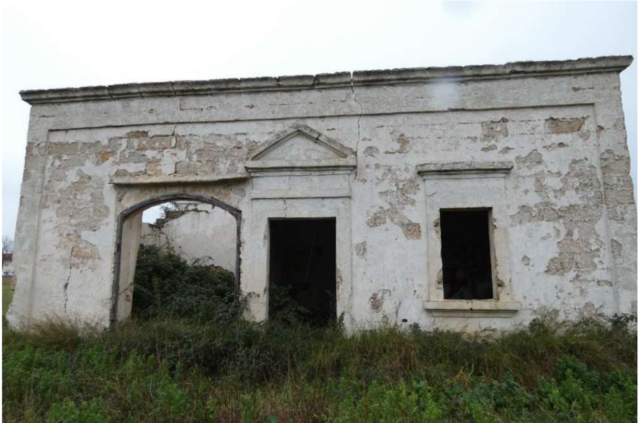
Figura 11. Area di intervento. Edificio 1, prospetto W.
