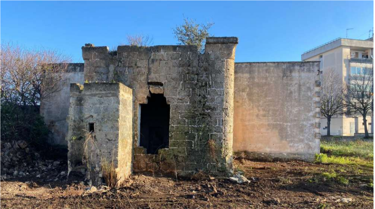
Figura 16. Area di intervento. Edificio 3, prospetto SW.
