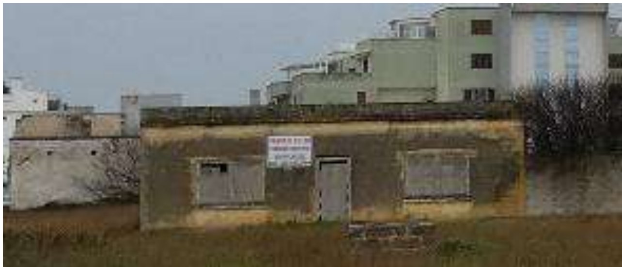
Figura 14. Area di intervento. Edificio 2, prospetto N.
